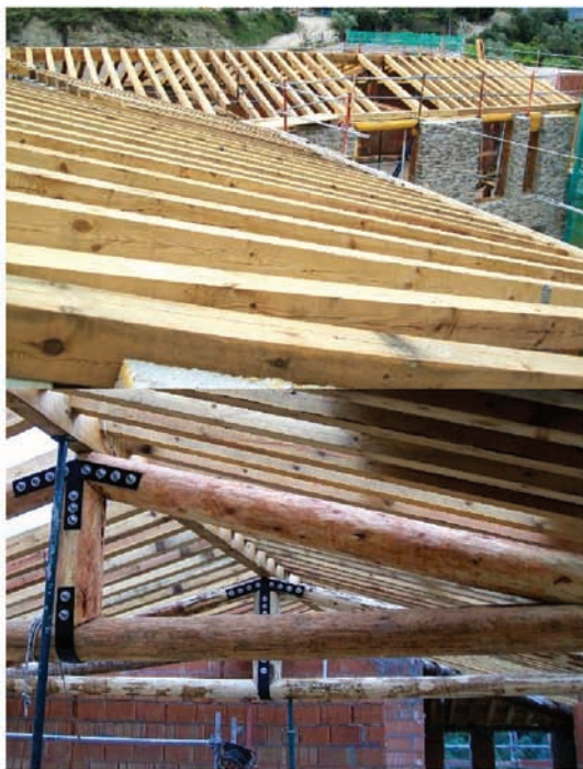
Colocación de estructura de madera de pino y vista interior.
