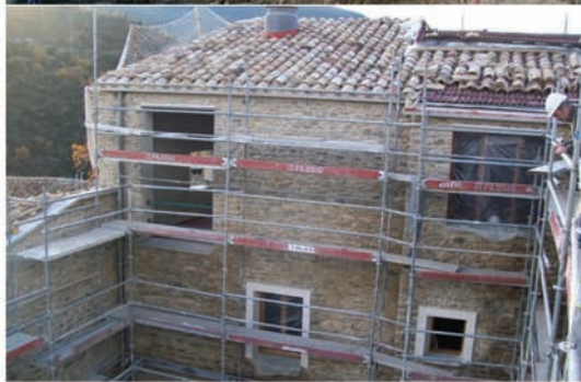
Fachada del patio, antes y después del recrecido, reformando huecos y alturas.
