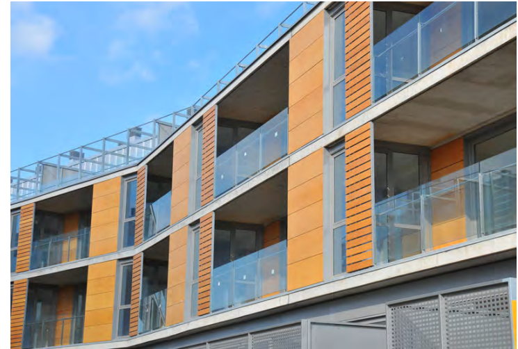
Façanes edifici A
