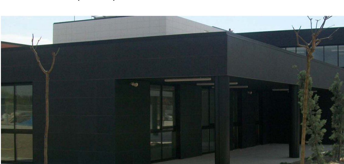
Detalle de la entrada principal del nuevo CEIP de Cubelles
