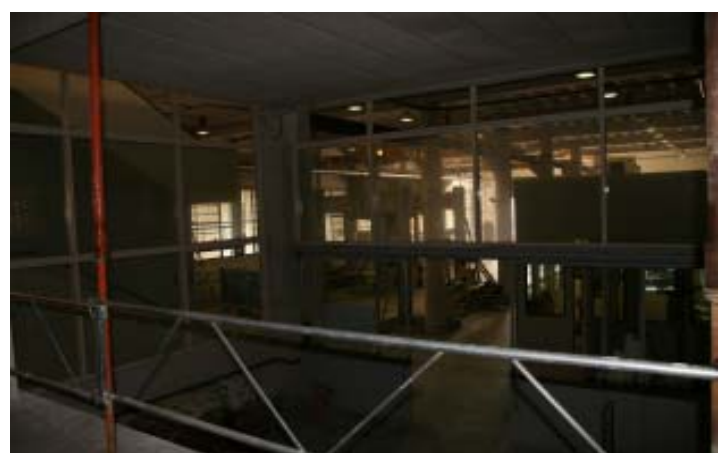
Vista interior del edificio
