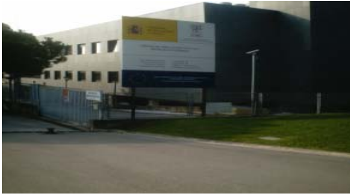
Fachada principal del edificio
