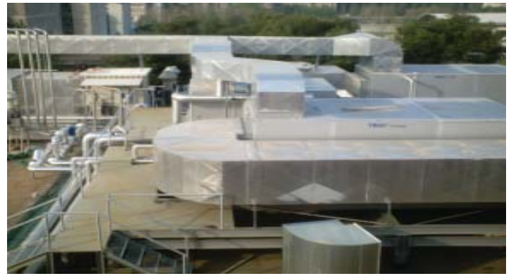
Instalaciones en cubierta. Sala Blanca
