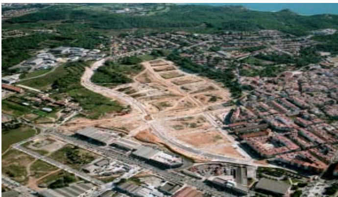
Vistas urbanización Vilanoveta (Área Ramón González)
