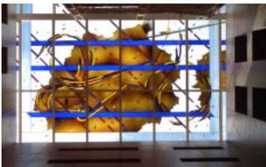
Lucernario situado en la planta superior del edificio, visto desde el patio central del hotel
